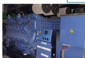
Groupe électrogène
